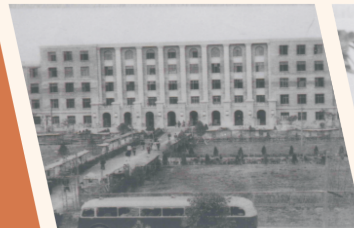
正在施工的主楼之三
