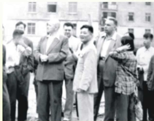
苏联专家和院领导视察主楼建设
