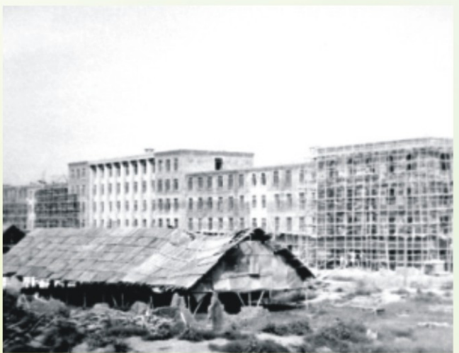
正在建设中的主楼
